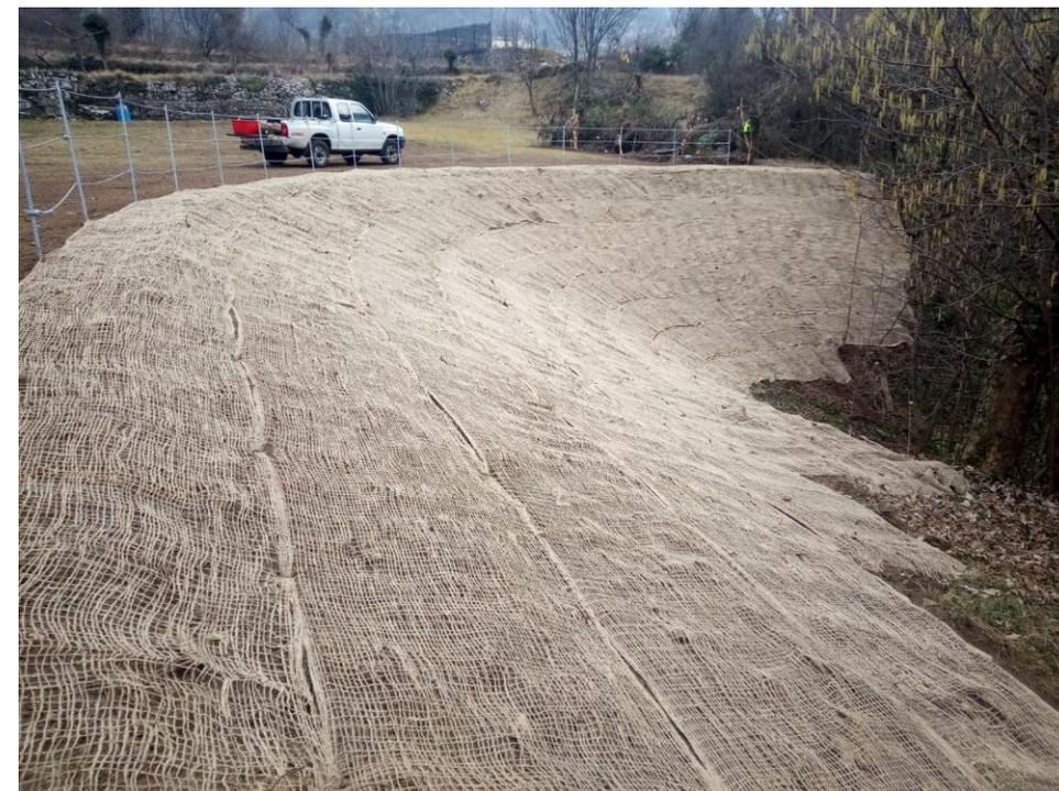
Intervento di riprofilatura di un tratto di versante in destra orografica, sopra la forra del rio Sallagoni nel comune di Drena. L'intervento si è reso necessario per risolvere alcune criticità geologiche legate alla nuova via ferrata «Caduti di Nassiriya», in fase di realizzazione all'interno della forra.
